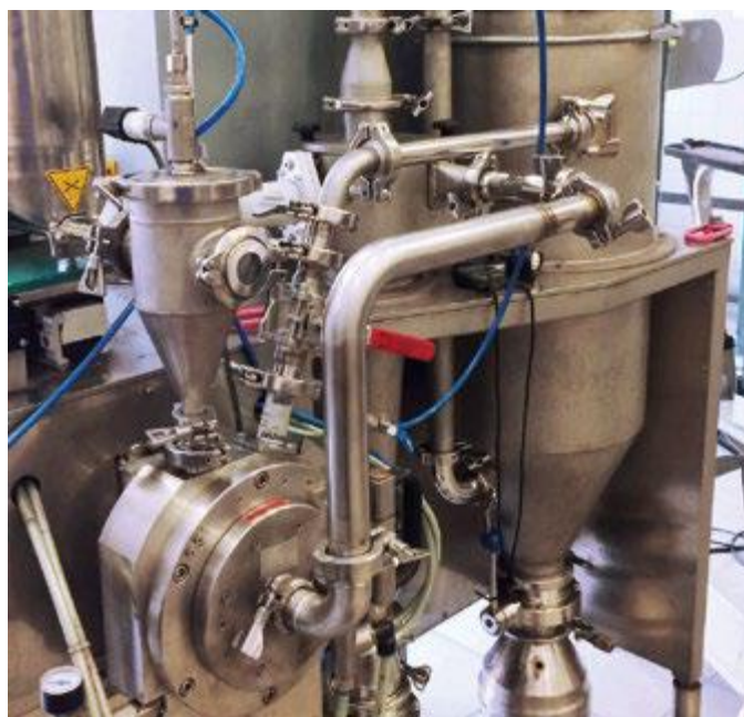
Sistema da laboratorio 10 con linea di scarico nel filtro antipolvere
